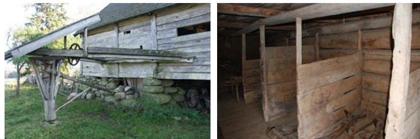
T.v. Tröskvandringen vidbyggd ladugården. En tröskvandring drar tröskverket med hjälp av en häst eller annan dragare.
