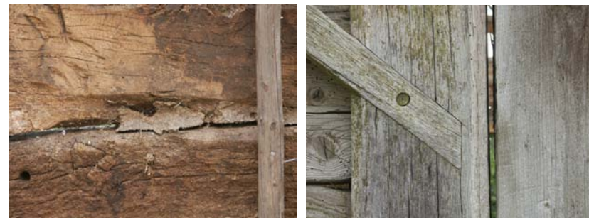
T.v. Ladugårdsväggen är tätad med kospillning. T.h. Detalj av ladugårdsvägg.
