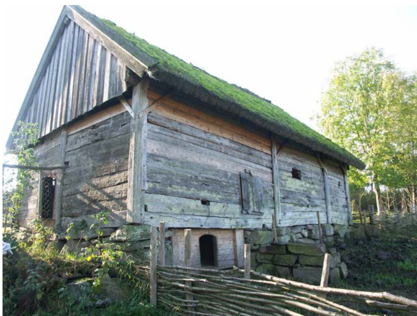
Ladugården sedd från nordost med grishyddan i sockelväningen.
